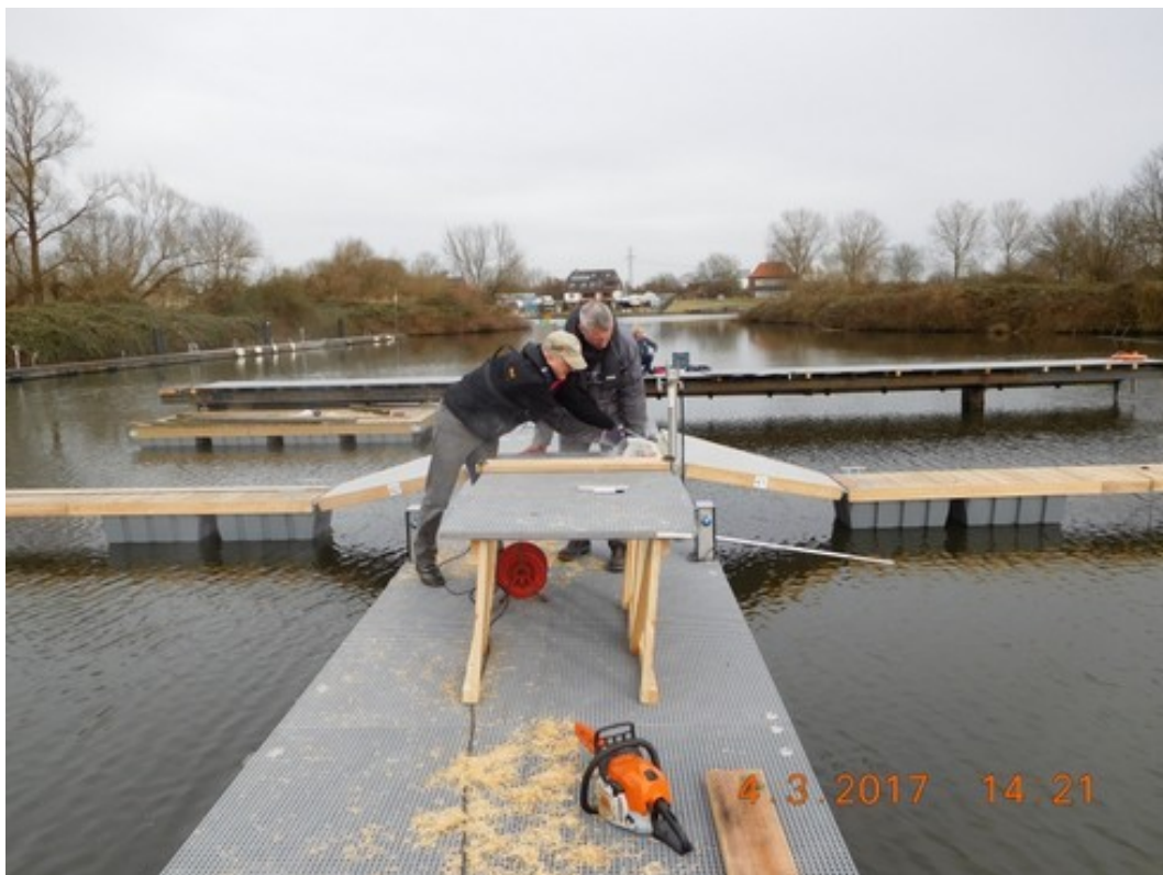
Zuschneiden der Kunststoffgitter
