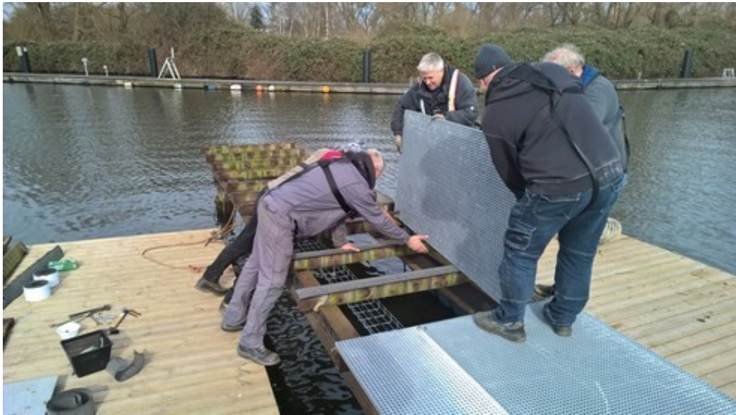
Auflegen der Kunststoffgitter. Gut dass wir die Arbeitspontons zum sicheren Stehen haben. Daher benötigen wir hier keine Akrobaten
